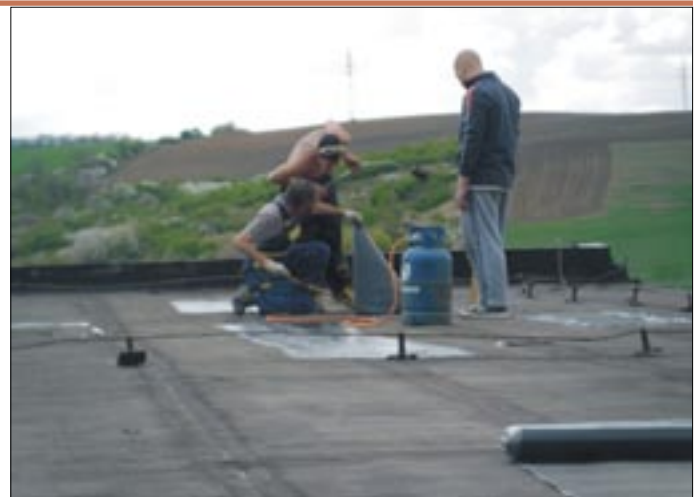
▲ Oprava strešnej krytiny nad posilňovňou.
